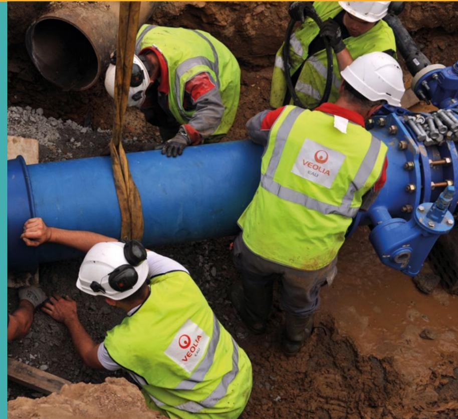
Déviation des réseaux d'eau sur le chantier de la 1<sup>ère</sup> ligne de Tram
