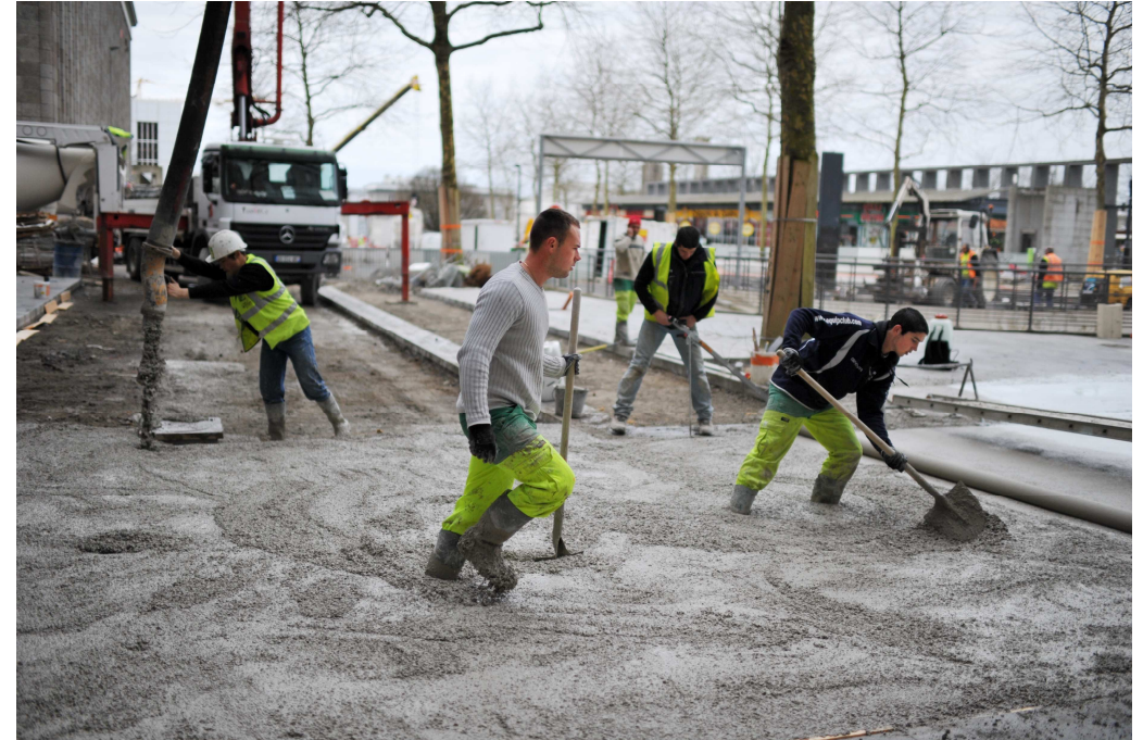
Pose de bordures et réalisation des revêtements
