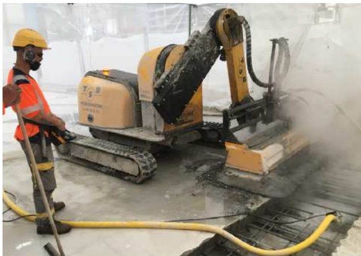
Hydrodémolition en surface du tablier
