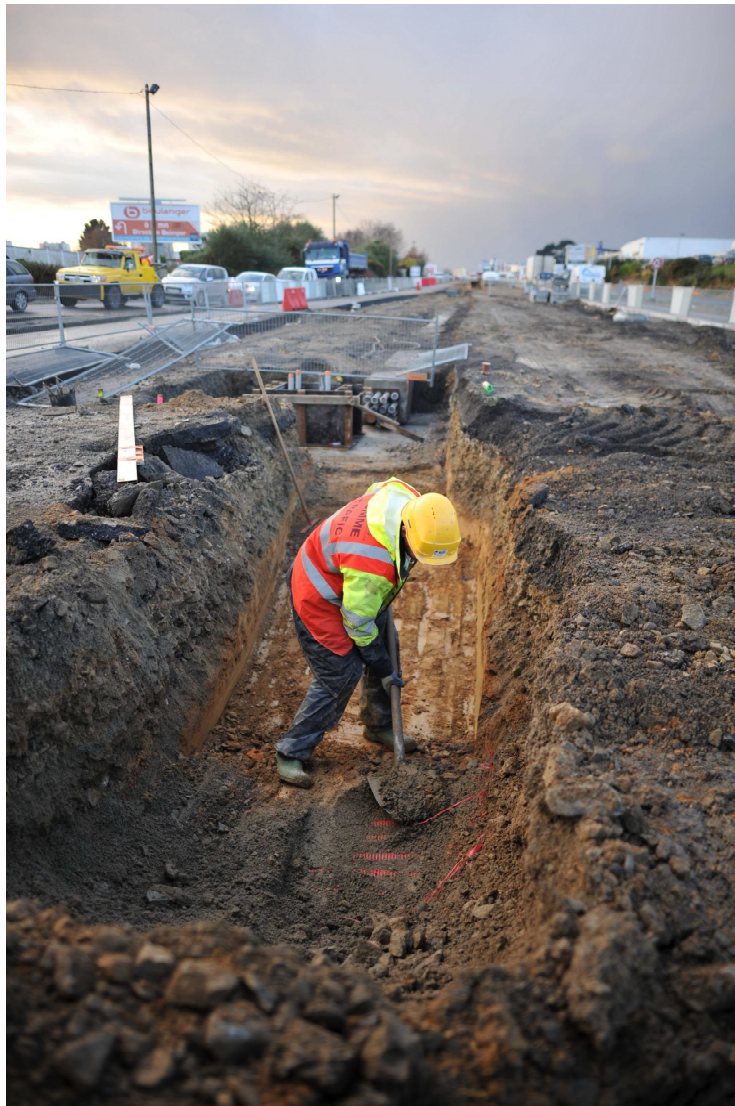
Terrassement et pose de réseaux
