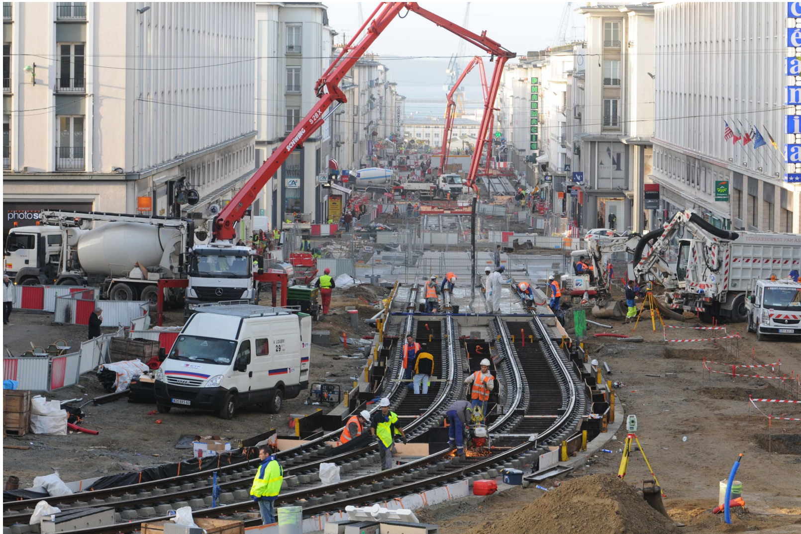
La réalisation de la plateforme
