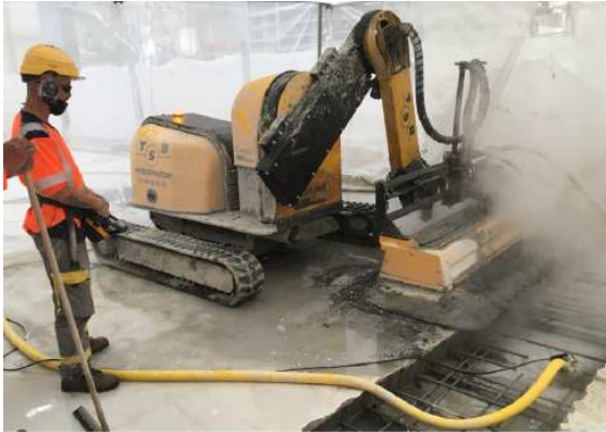
Hydrodémolition en surface du tablier
