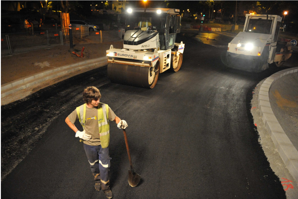
Pose de bordures et réalisation des revêtements
