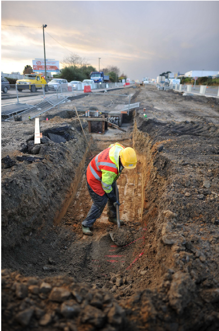
Terrassement et pose de réseaux
