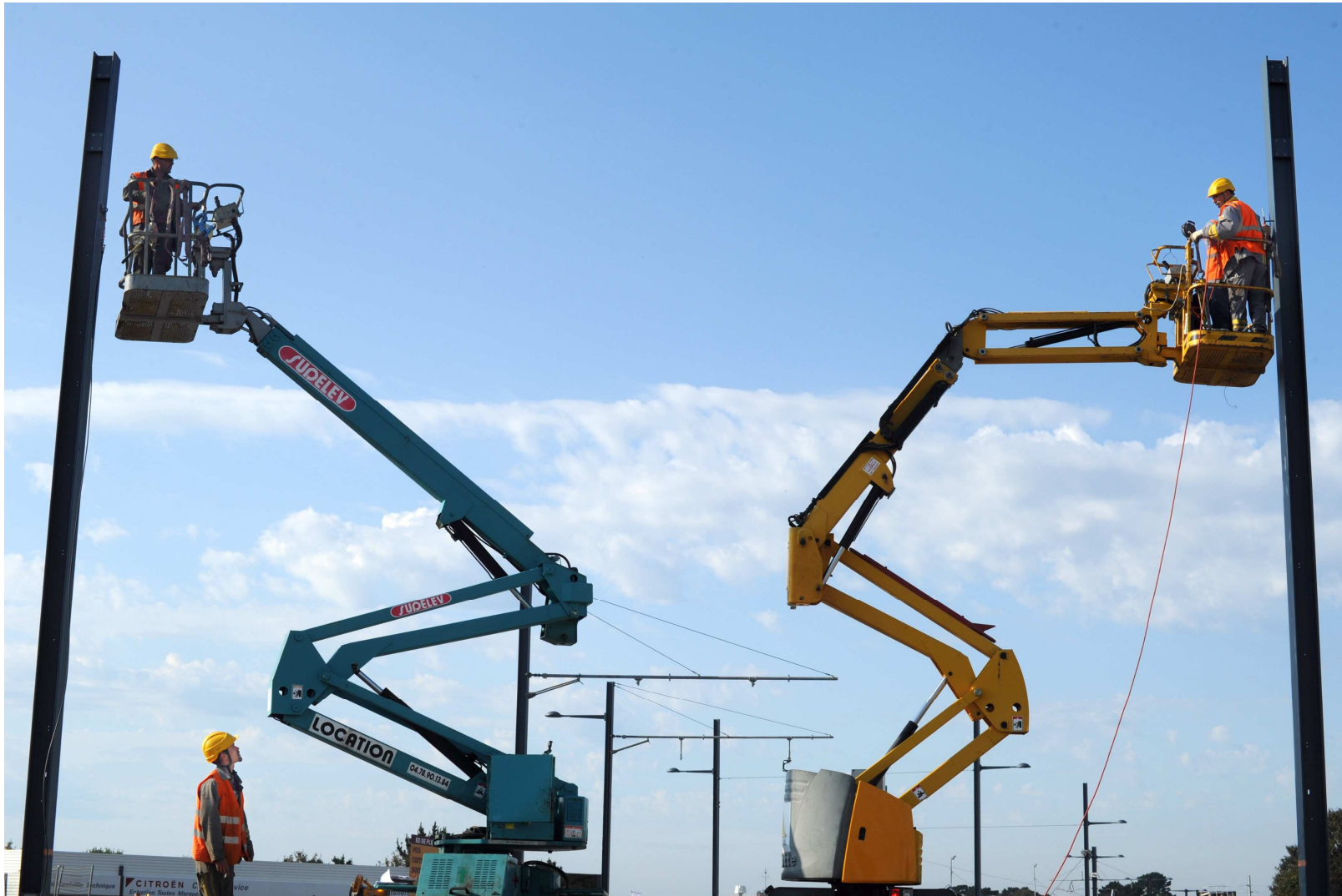
Pose des équipements: ici la ligne aérienne de contact
