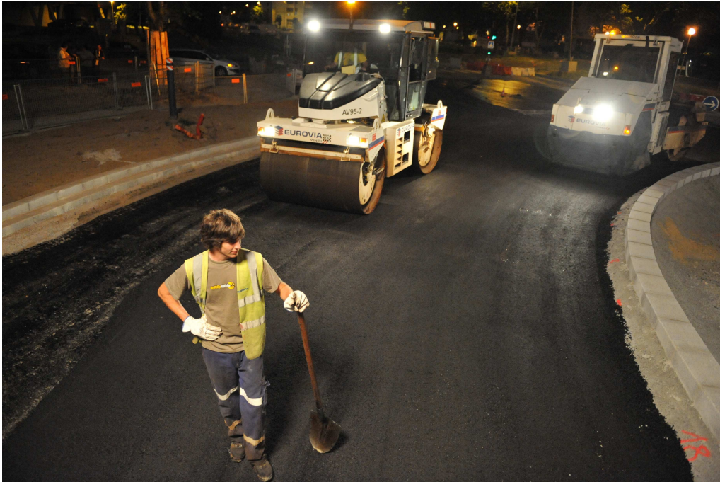
Pose de bordures et réalisation des revêtements
