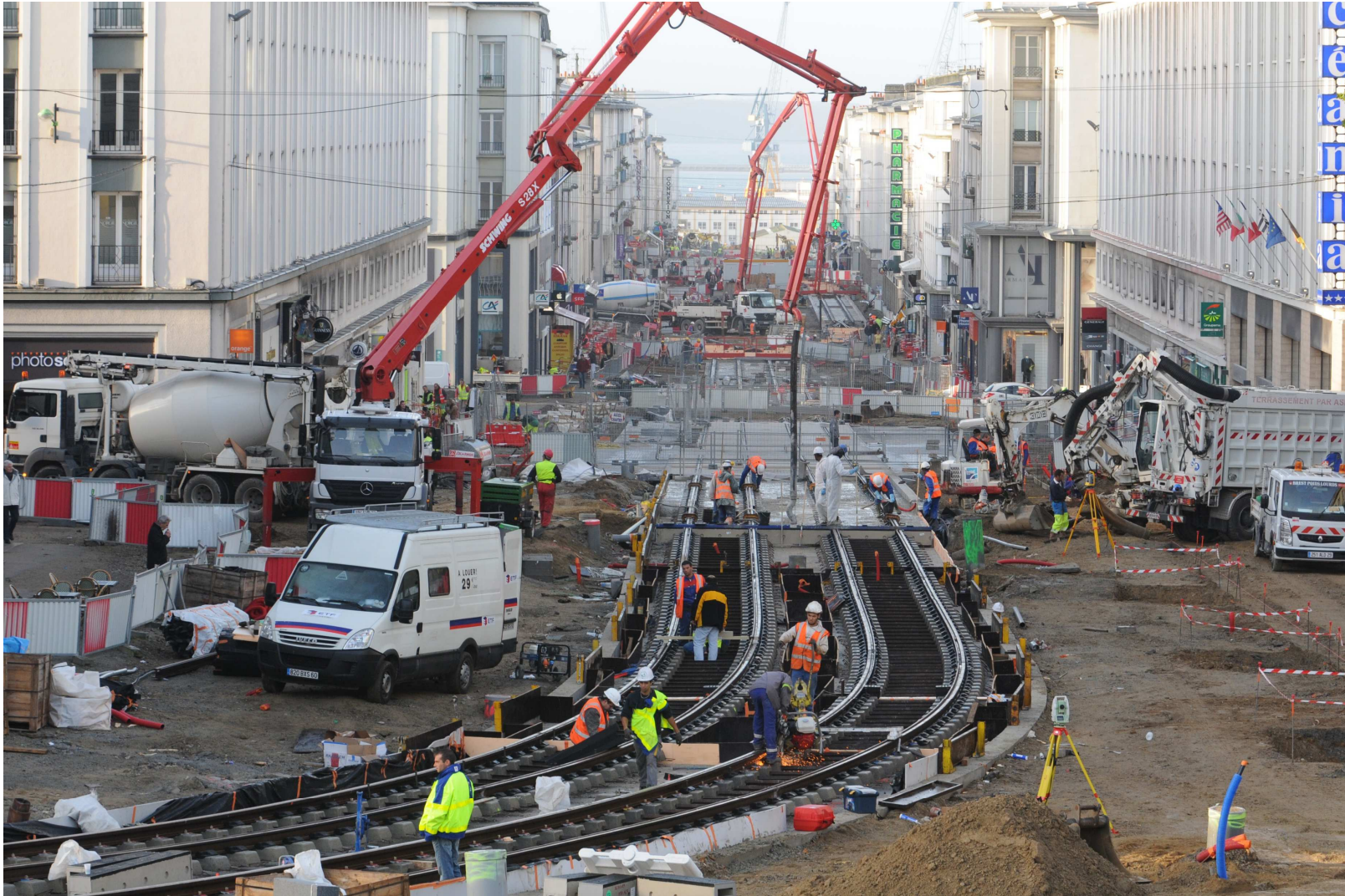
La réalisation de la plateforme
