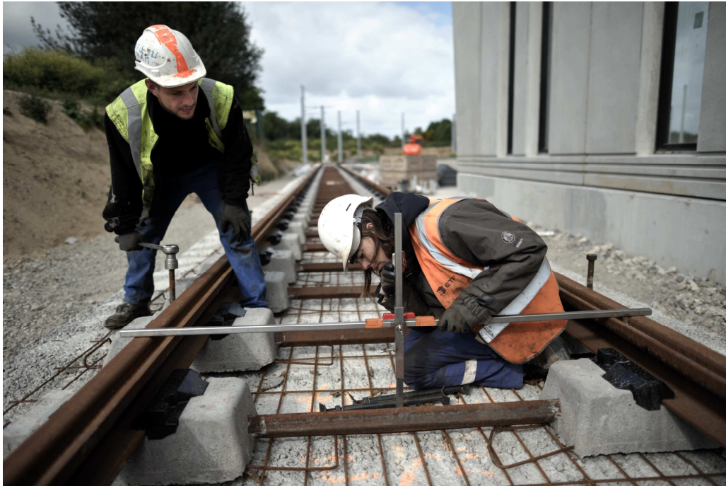
Le réglage de la plateforme
