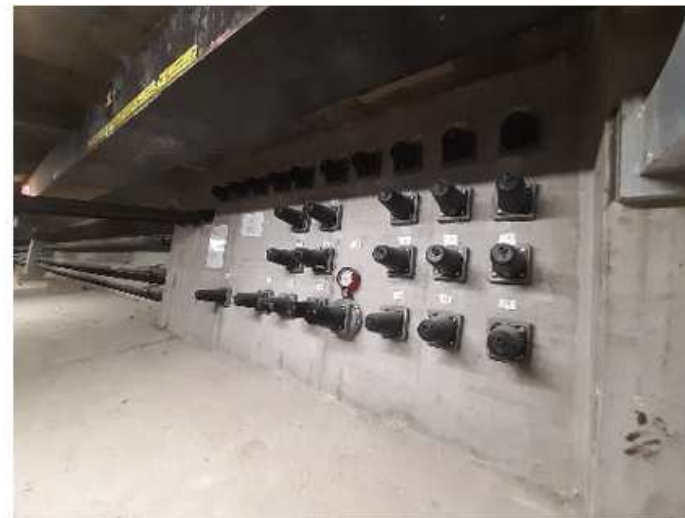
Bossage précontrainte - 3 - Bossage réalisé
